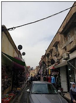
Figure-4- 56 : Etat de bâti côté sud.
