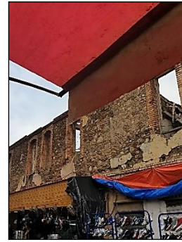
Figure-4- 57 : Etat de bâti côté ouest.
