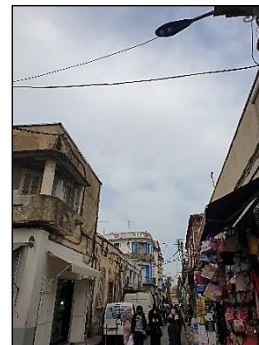
Figure-4- 58 : Etat de bâti côté est.
