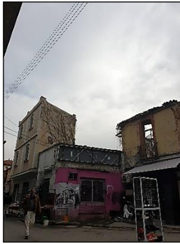
Figure-4- 55 : Etat de bâti côté nord.
