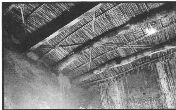
Figure 21 : la toiture d'une maison à Adjahil Source : Auteur
