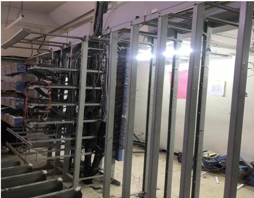
Figure II. 28: L'armoire du répartiteur
