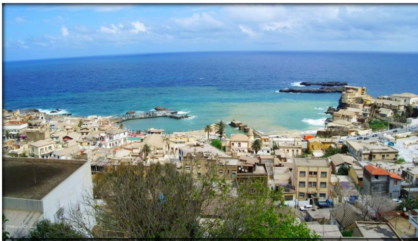
Fig.05: Vue sur le port Mers ed debban Source : https://www.ebay.fr
