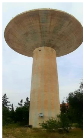
Figure III.5 : Photo réelle du château d'eau.
