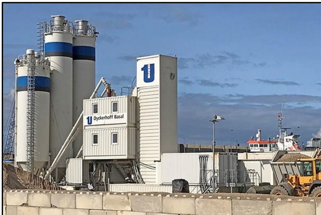
Figure 2-1: Centrale à béton.
