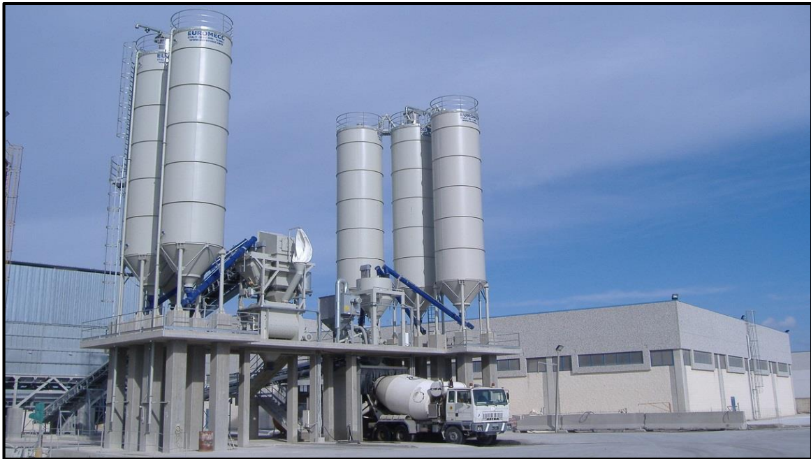
Figure 2-4: Centrale à béton fixe.
