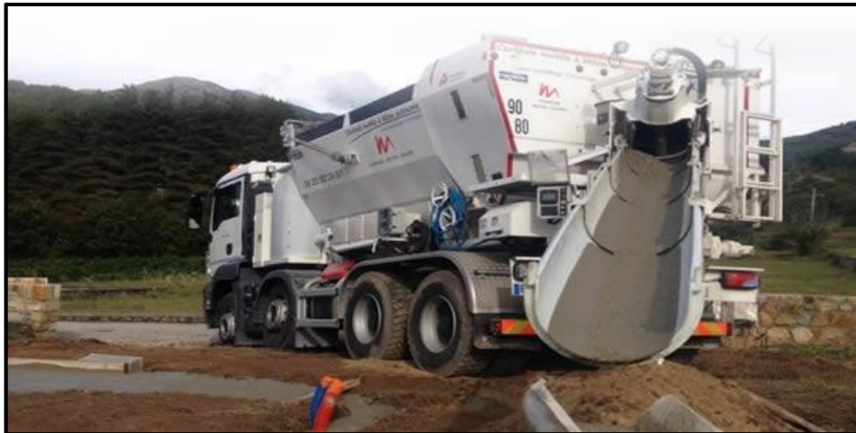
Figure 2-5: Centrale à béton mobile.
