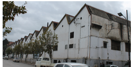
figure95: Vue sur la façade du hangar ex SNTV, source auteurs
