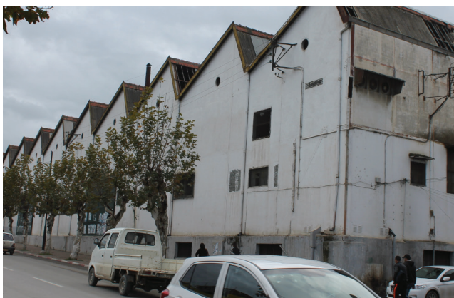
figure33: Photo du hangar ex SNTV, source auteurs
