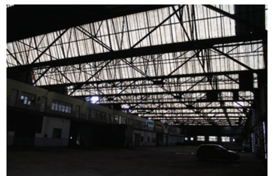
figure101: Vue sur la toiture du hangar ex sntv, source auteurs
