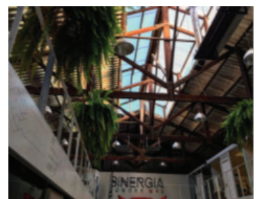
fig64: Vue sur la toiture
