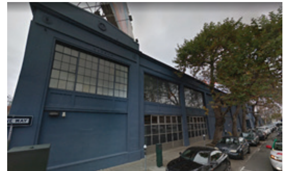
figure79: Vue sur la façade principale d'ATLASIAN archdaily.com
