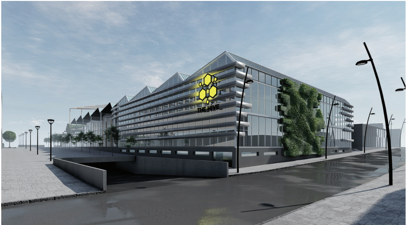
figure: Vue sur la partie réhabilitée, façade est donnant sur la RN01
