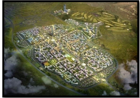
Figure 02-10-vue sur l'ensemble du future ville nouvelle de BOUINAN
