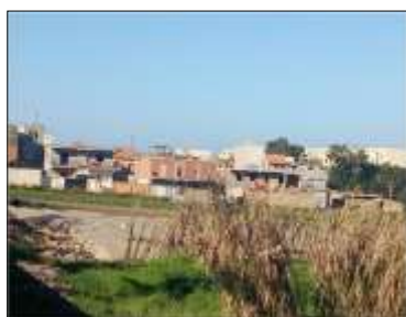
Figure 97 Habitation individuelle Source: prise par les auteurs le 08/01/2019 à 10:30
