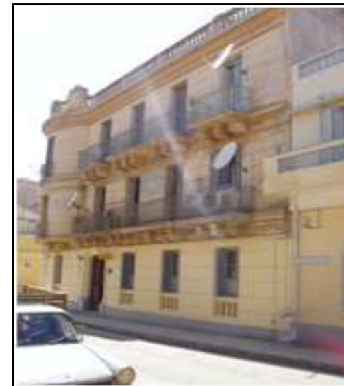
Figure 70 Construction en R+2 Source: prise par les auteurs, 2019
