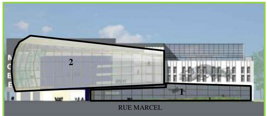
Figure 29 Façade du MOBE Source: www.atelierphilip.fr , traité par les auteurs.
