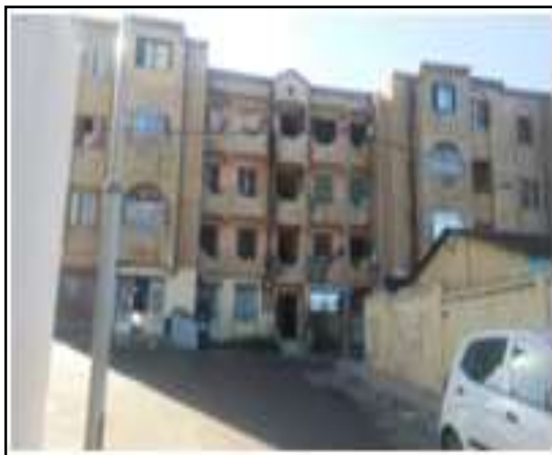
Figure 69 Construction en R+3 Source: prise par les auteurs, 2019
