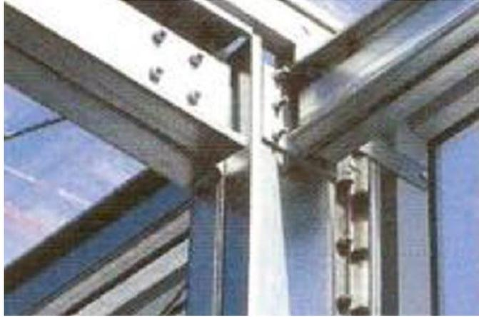
Figure VII.2 : Structure en profils minces boulonnés. Viaduc espace info à Millau.
