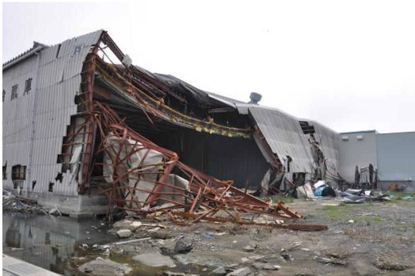
*Figure IV.12 : Effets du tremblement de terre au Japon Tohoku 2011 sur les structures métalliques.*
