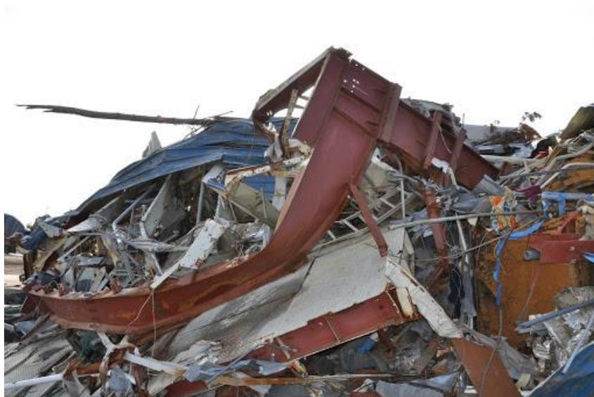
*Figure IV.13 : Effets du tremblement de terre au Japon Tohoku 2011 sur les structures métalliques.*
