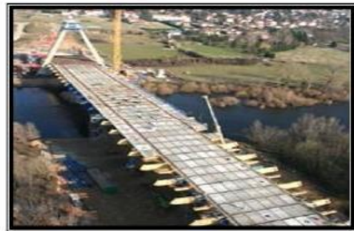
Ouvrages d'arts ponts (tabliers),
