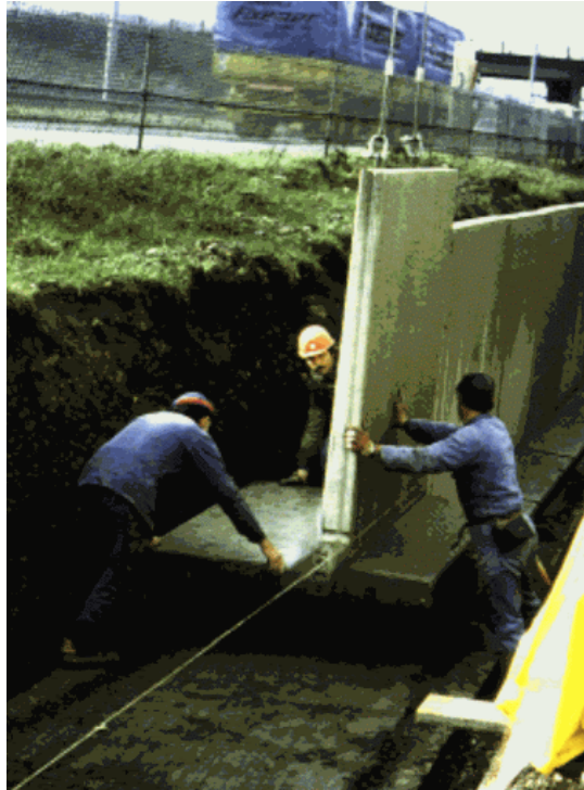
Figure 1.11: exemple d'un mur cantilever
