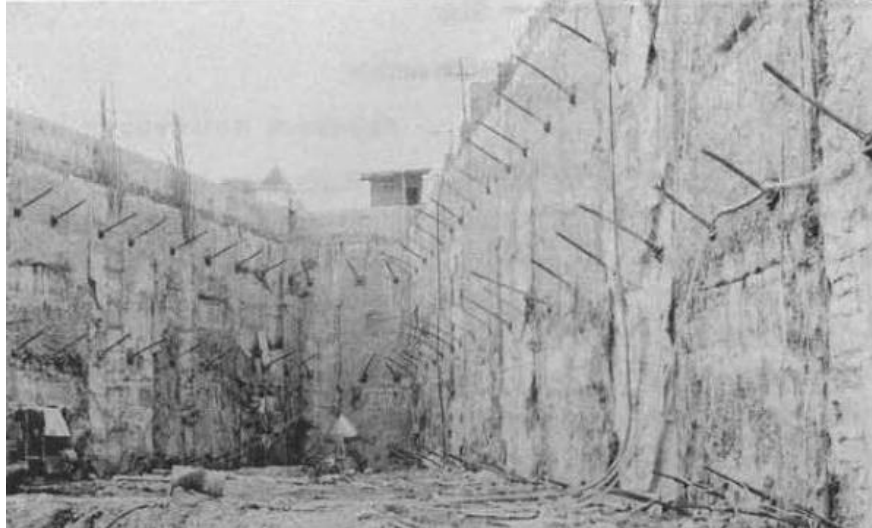
Figure 1.4. Photo de la méthode d'excavation ancrée (1)
