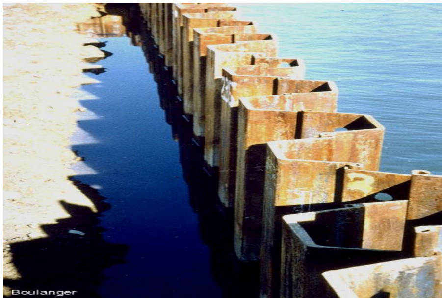
Figure 1.13. Illustration de la serrure d'un rideau de palplanche (3)
