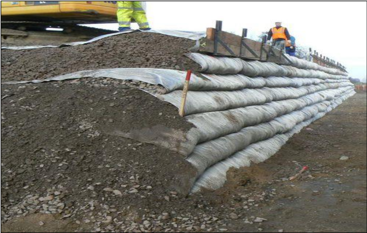
Figure 1.12 : l'installation des géotextiles
