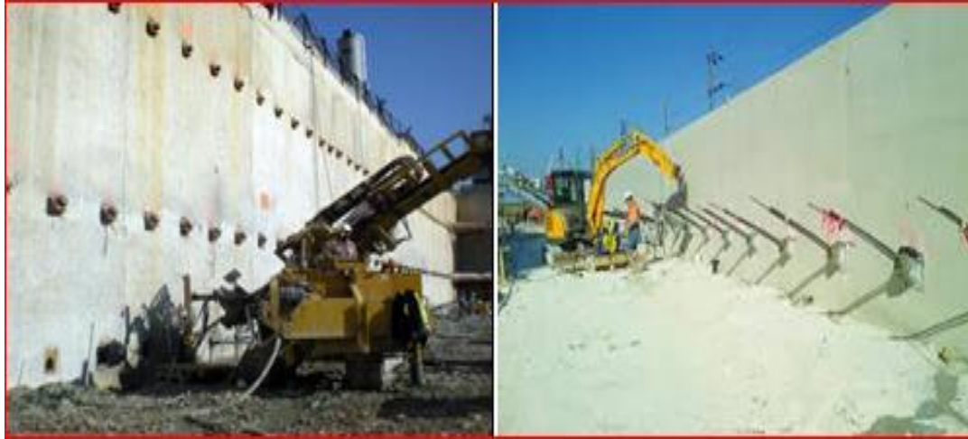
Figure 1.11 : installation des tirants d'ancrages
