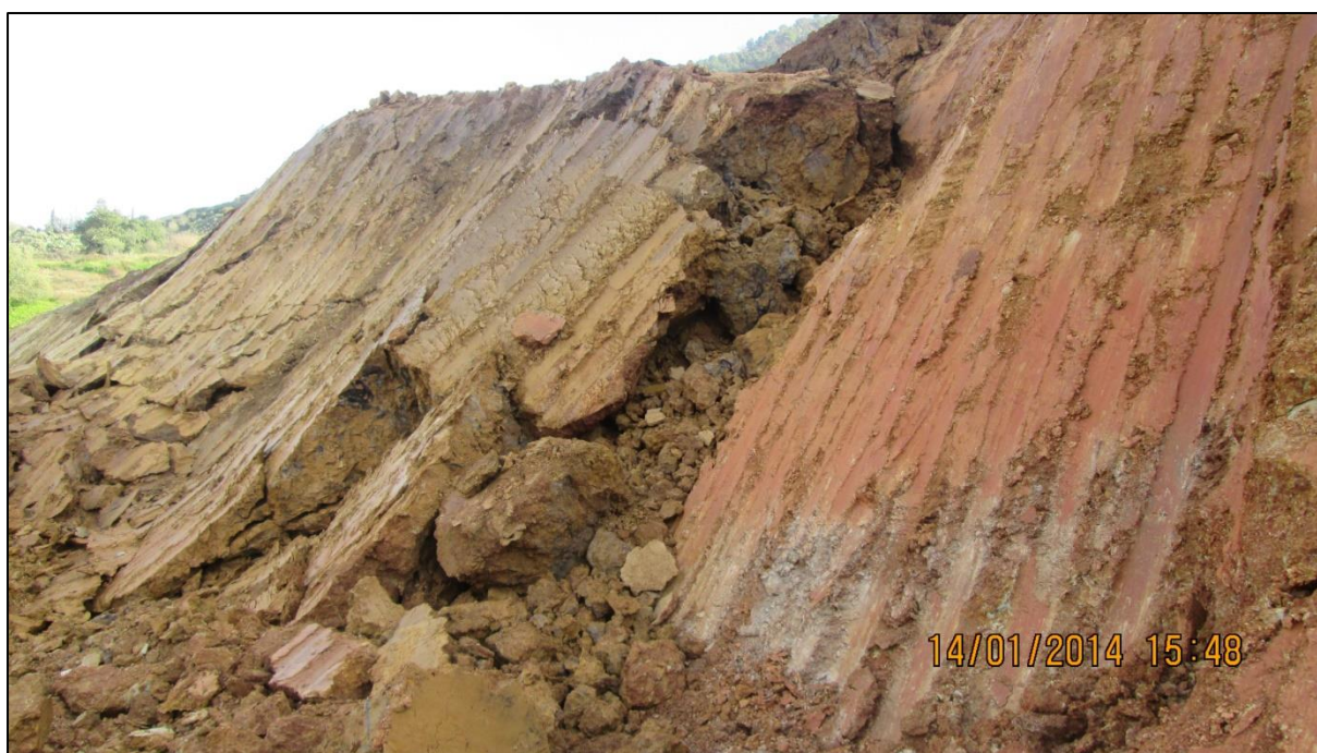
Figure 1.5 : Glissement de rive droite barrage kfed damous
