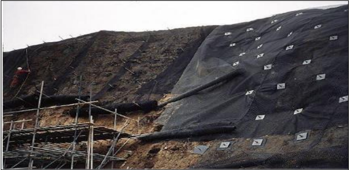
Figure 1.13 : Un versant stabilisé par clouage
