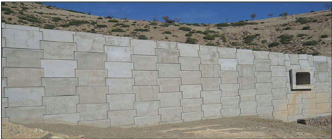
Figure 1.14 : Terre armée, type Freyssissol
