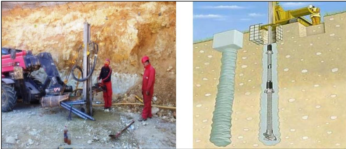
Figure 1.16 : installations des pieux
