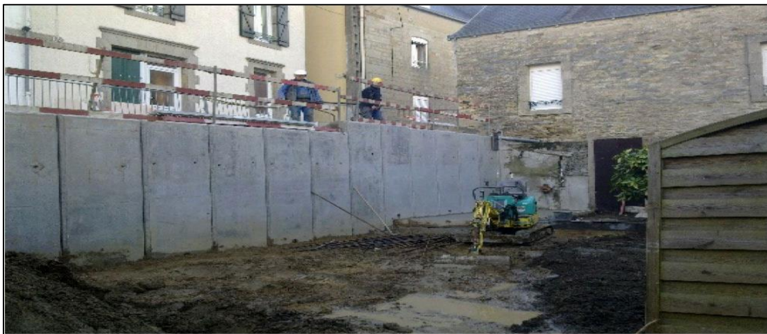
Figure 1.15 : fabrications des murs de soutènements
