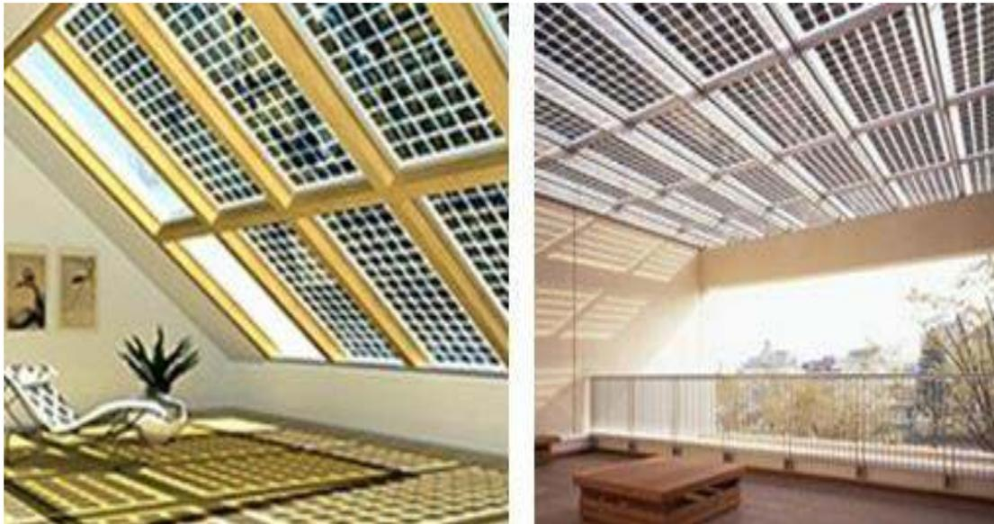
**Fig33-** Le PV pour les toitures vitrage
