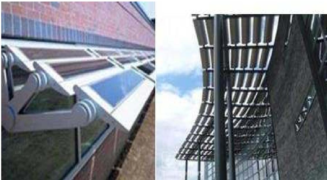
**Fig37-** Le PV pour les brises solaire
