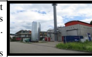
Figure 13- 1L'usine de cogénération vue extérieure
