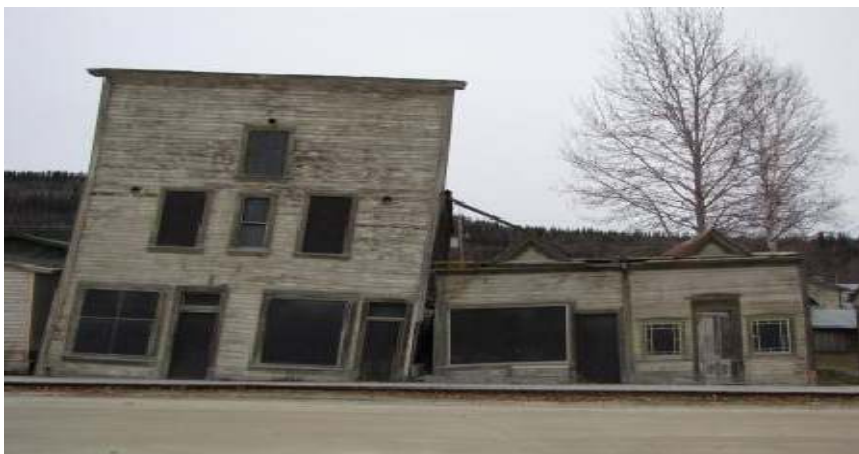
Figure I.11: tassement différentiel.
