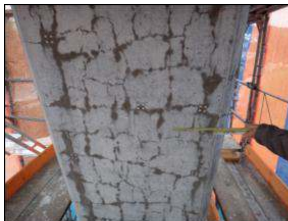
Figure I.9: épaufrures dues à l'alkali-réaction
