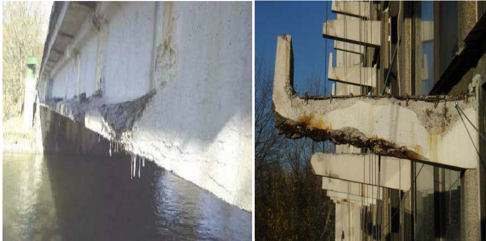
Figure I.6: Structures atteintes par la carbonatation.
