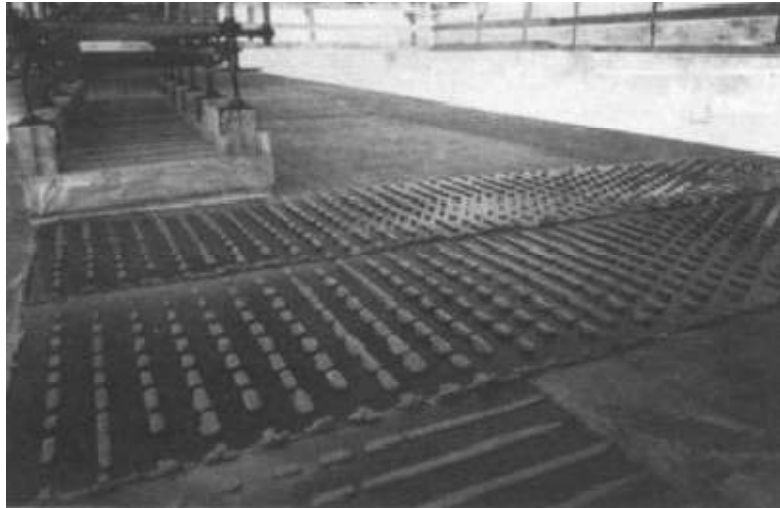
Figure I.23 : plaques d'acier collées.
