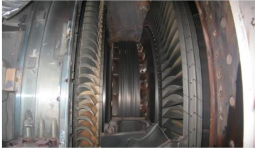
Figure I-2 : Ensemble rotor de la bobine de turbine
