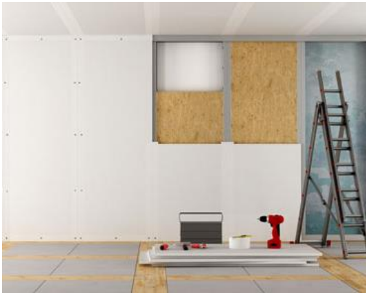
Figure II.7 : Mur en plaque au plâtre.
