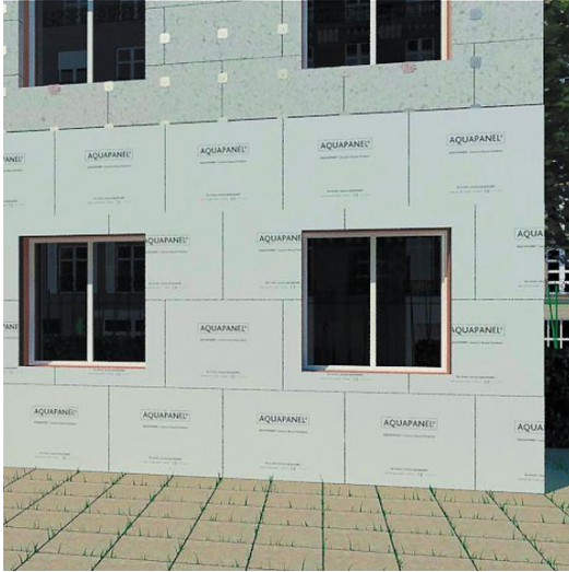
Figure II.8 : Mur extérieur (plaque en ciment).
