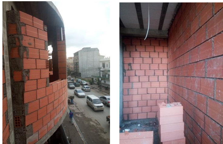
Figure II.6 : Maçonneries extérieur et intérieur.
