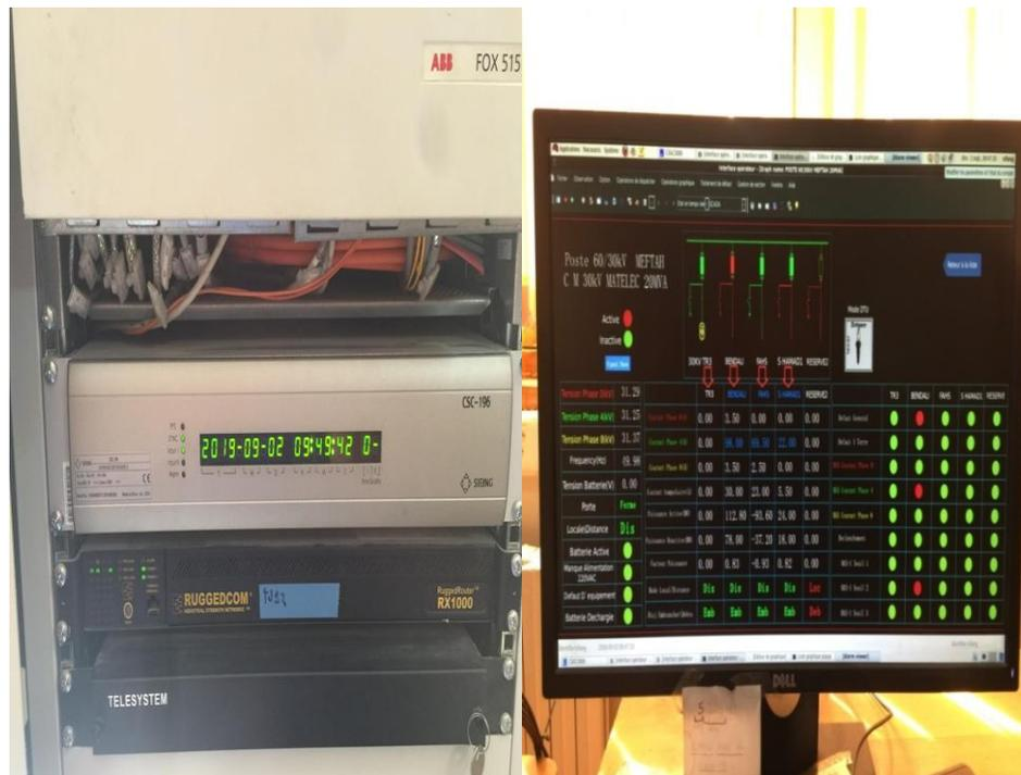
Figure 26 : RTU déportée et le schéma unifilaire de la cabine mobile de MEFTAH
