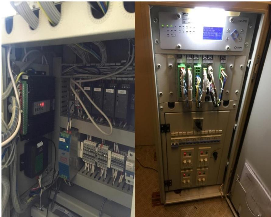
Figure 25 :RTU locale et le modem du communication au niveau du CM de MEFTAH
