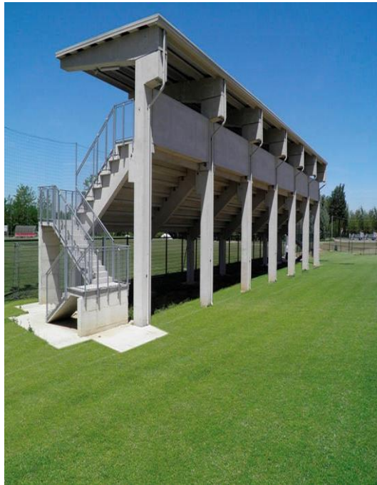
figure 96 : Tribunes en béton armé, source : www.archiexpo.fr
