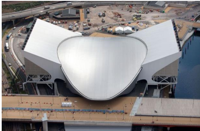
figure 60 : Photo aérienne du centre aquatique, source : www.batiactu.com
