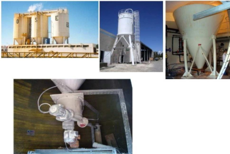
**Figure 1.9** Equipement de stockage et de dosage de la chaux.
