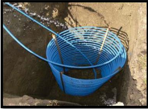
Fig174 : captage géothermique vertical;( source : futures sciences
