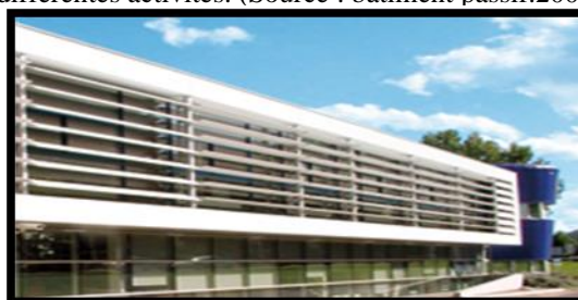
Figure14 : Brise soleil (Source : tellier.2009)
