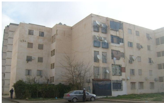
Fig. 6.85. Les espaces réservés pour le parking Source : Auteur
