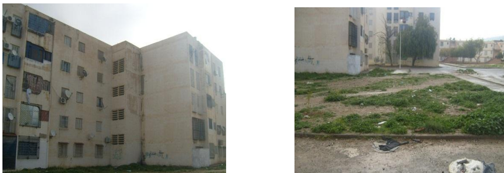
Fig. 6.86. Des terrains vagues où l'herbe pousse naturellement Source : Auteur
