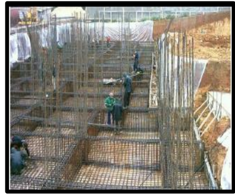
Figure : les fondations en radier
