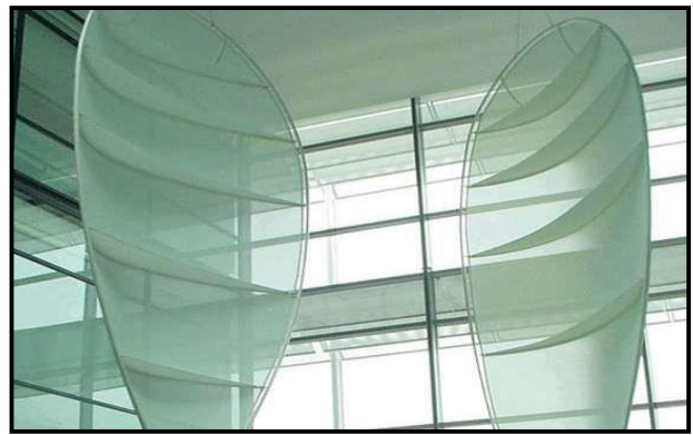
Figure 125 : Tissage Composé de de : 36% Fibre de verre - 64% PVC
