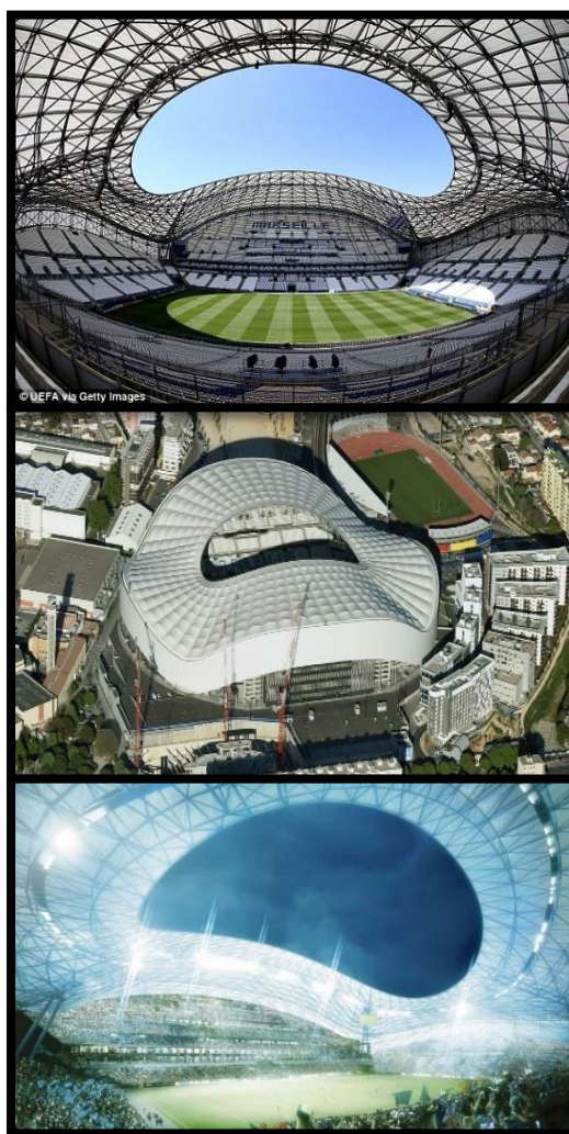
Figure 135: . Couverture du stade vélodrome – Marseille -
