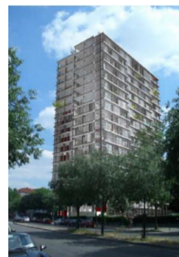
Figure N°26: La tour Bois le prêtre (après). Source: Internet.
