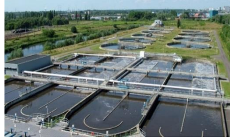
Figure N° 76 : Station d'épuration des eaux usées. Source : Google image.
