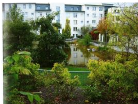
Figure N° 61 : Façade d'immeuble à Dunkerque.
