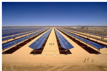
Figure N° 72 : Panneaux photovoltaïque. Source : Google image.
