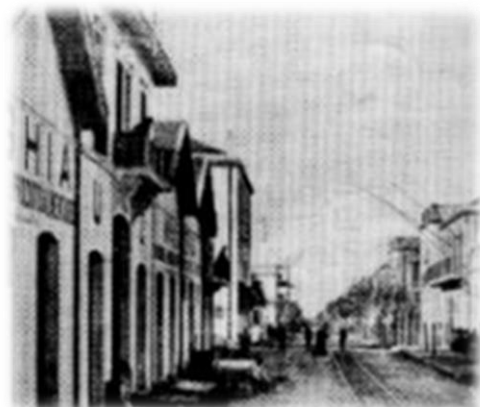
Figure N° 46 : Ligne de tramway. Source : Internet.
