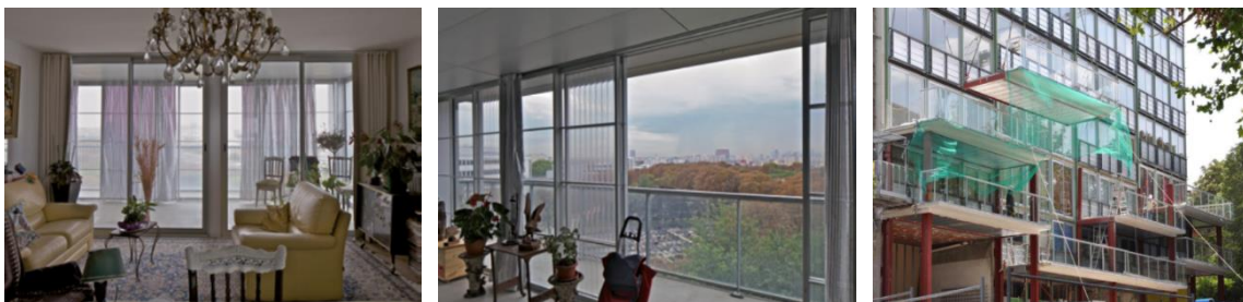
Figure N°30: Une vue sur l'intérieur après l'extension .Source : Vers de nouveaux logements sociaux 2.
