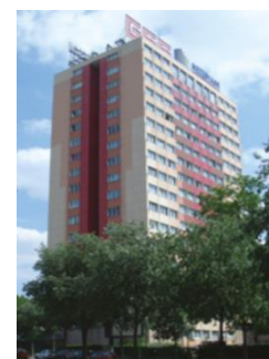
Figure N°25: La tour Bois le prêtre (avant). Source: Internet.
