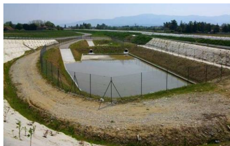
Figure N° 75: Bassin de récupération des eaux pluviales. Source : Google image.
