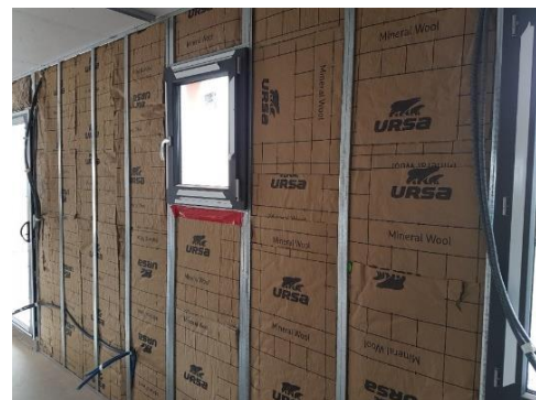
Figure : La pose de l'isolant par l'intérieur. Source : internet.
