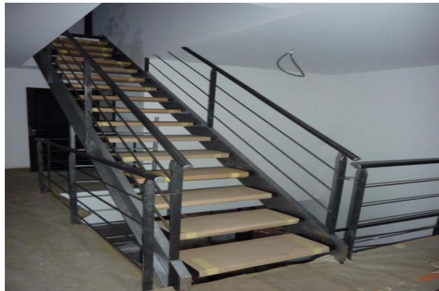
FIGURE.I.6. Gard- corp métallique .
