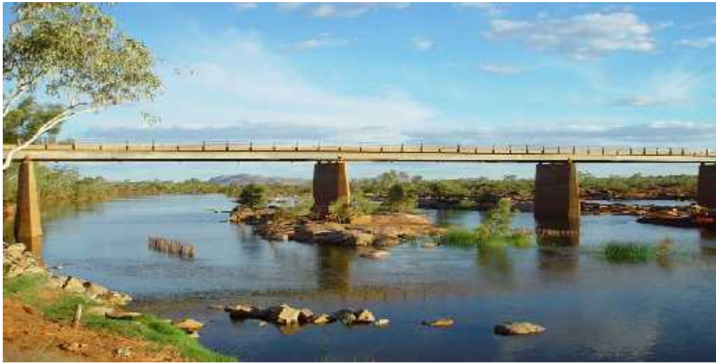
Figure I-15 : pont a poutres [2]
