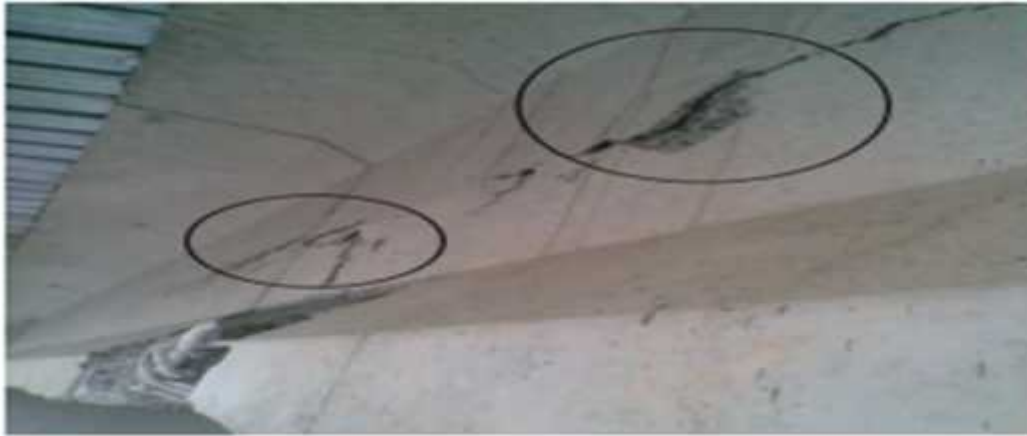
Figure I-42 : Epaufure cause par le choc [5]
