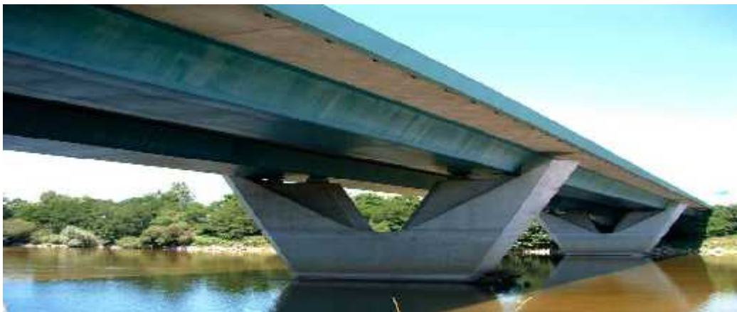
Figure I-16 : pont en caisson [2]
