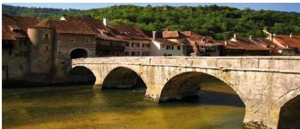
Figure I-9 : pont en maçonnerie [2]
