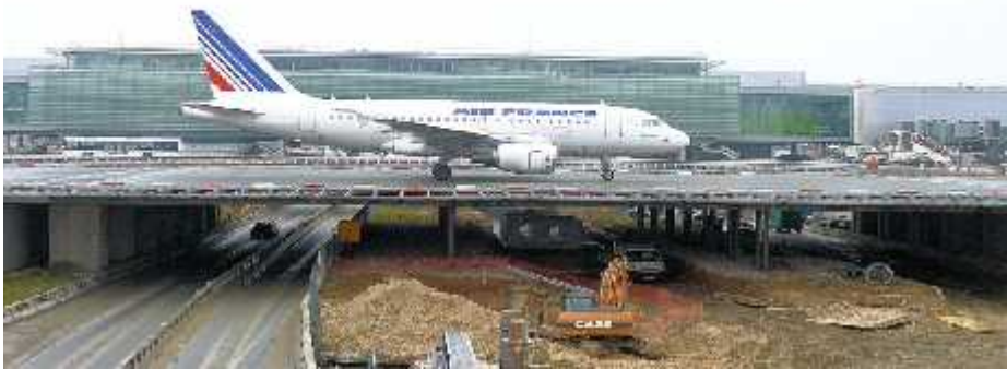
Figure I-4 : pont pour avion [2]
