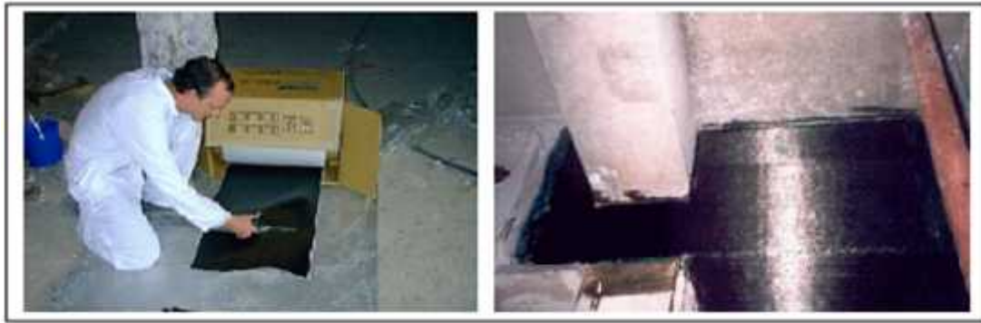
Figure I-65 : Préparatifs pour placage des composites CFRP [13].
