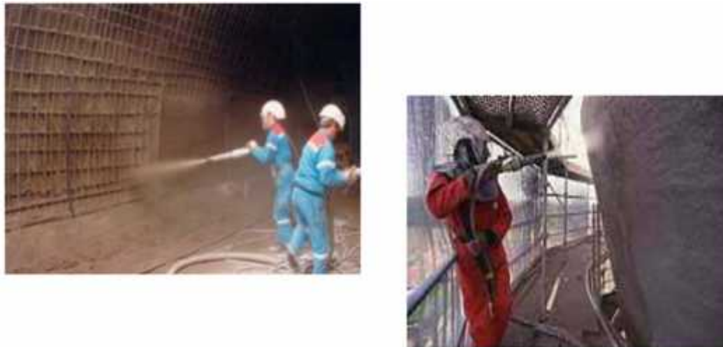
Figure I-54 : Technique de béton projeté [2]
