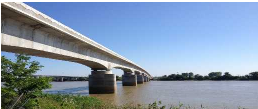
Figure I-12 : pont en béton précontraint [2]
