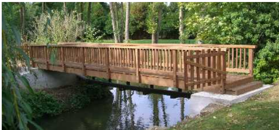
Figure I-8 : pont en bois [2]
