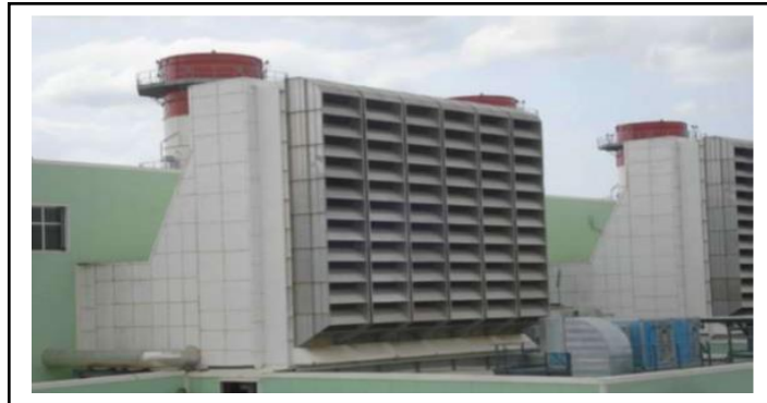
Figure1.7 Système d'admission d'air.
