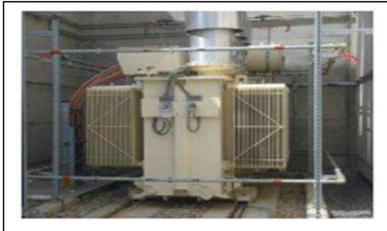
Figure 1.11 Transformateur auxiliaire.
