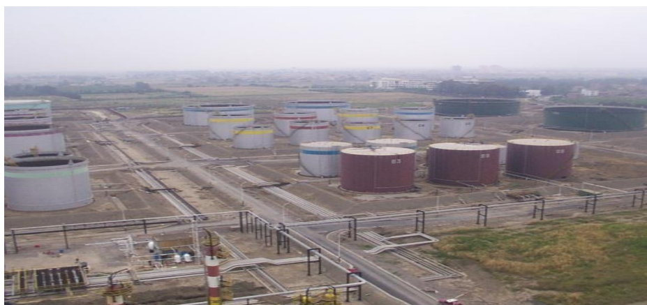
Figure 1. 4 : Parc de Stockage de la raffinerie d'Alger
