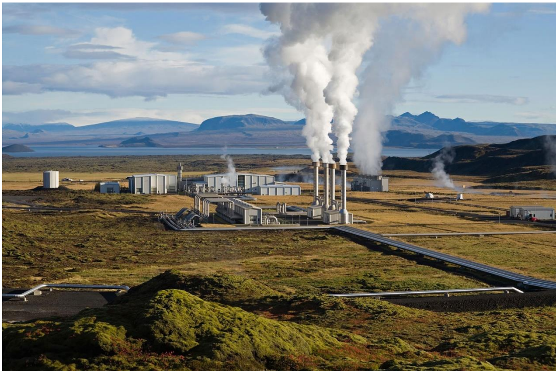
Figure 2.1 : central de l'énergie géothermique
