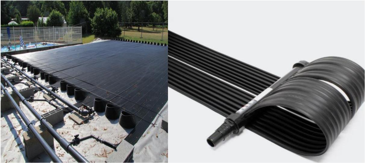
**Fig.9.**Un capteur solaire non vitré "moquette".
