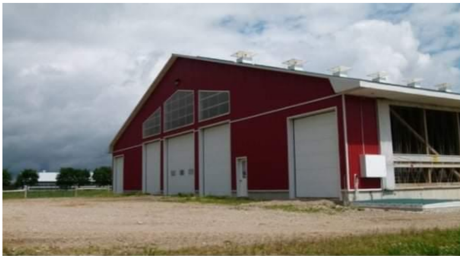
Figure 11 : Ventilation naturelle d'une étable laitière (Tyson et al., 1998).
