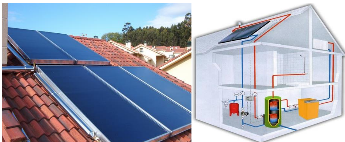
Figure 2.3 : Chauffe-eau à circulation forcée.
