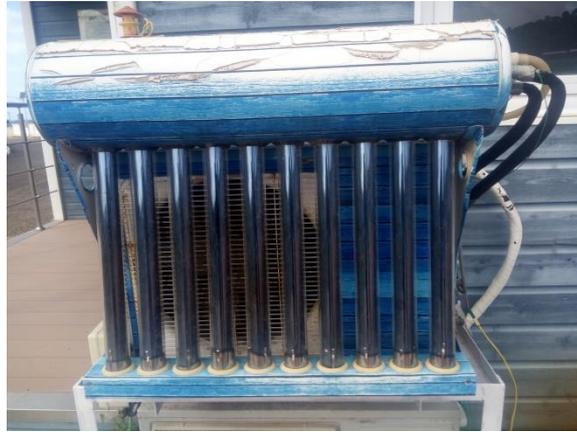
**Figure 4.1.** Photo de climatiseur solaire hybride.
