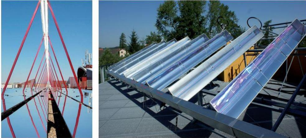
Figure 2.31. Exemples de capteurs à concentration et à système de suivi du soleil à un axe (tracking) [25].
