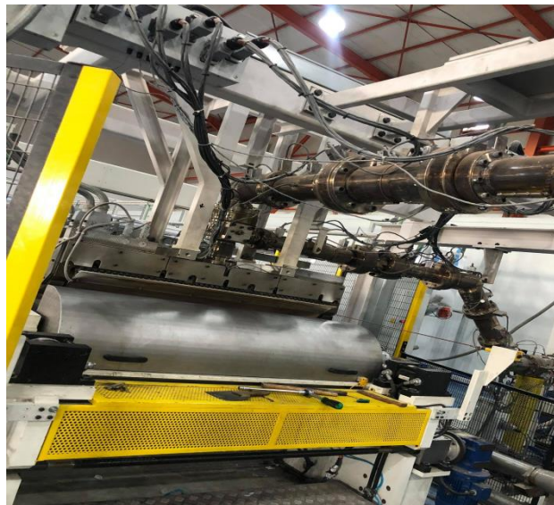
Figure V .22 : Photographie montrant Cylindre de compression et refroidissement
