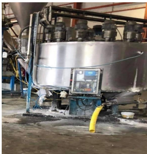
Figure V .9 : Photographies montrant la cuve de lavage
