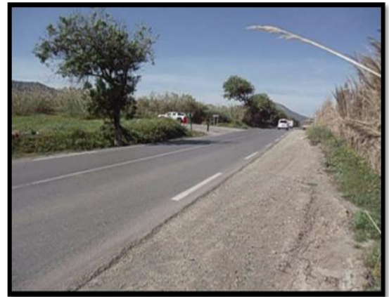
Figure II.6 : Fin du tracé routier (PK17+117)
