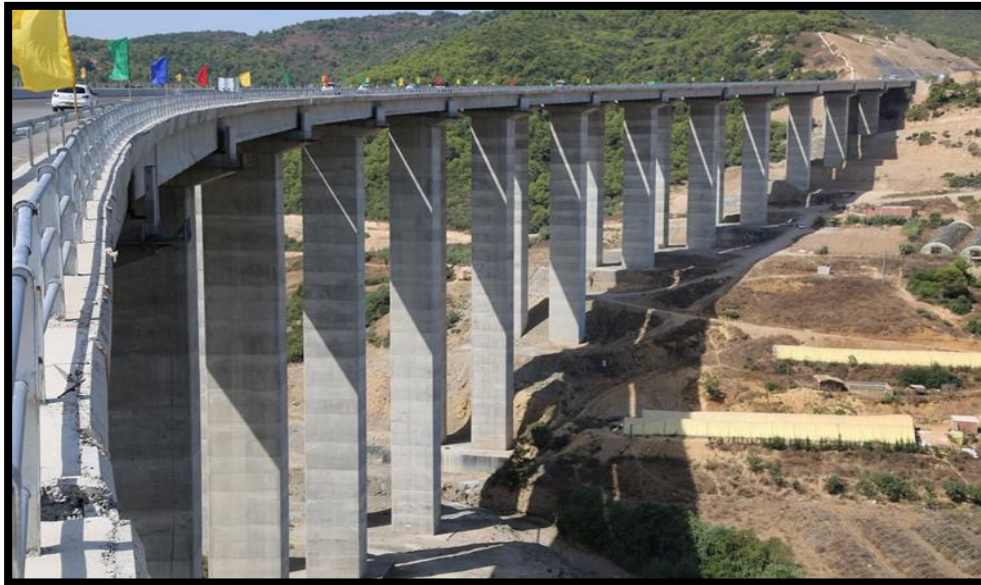
Figure IV.18 : viaduc liant les 2 villes Cherchell et Sidi Ghiles [8]
