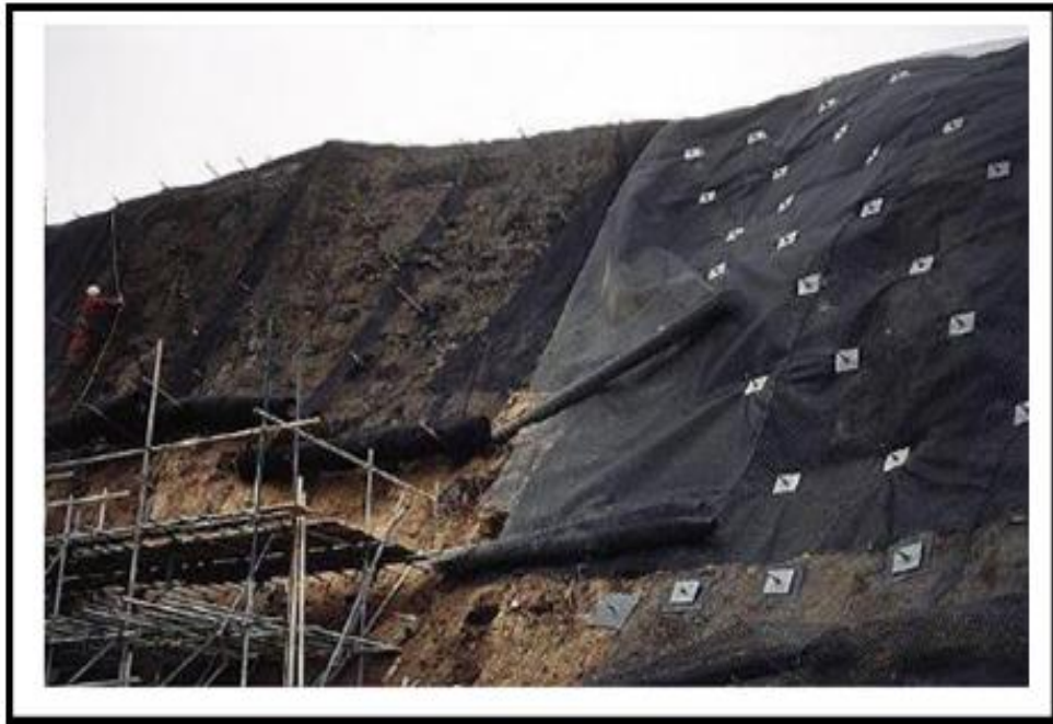
Figure I.30. Un versant stabilisé par clouage[12]
