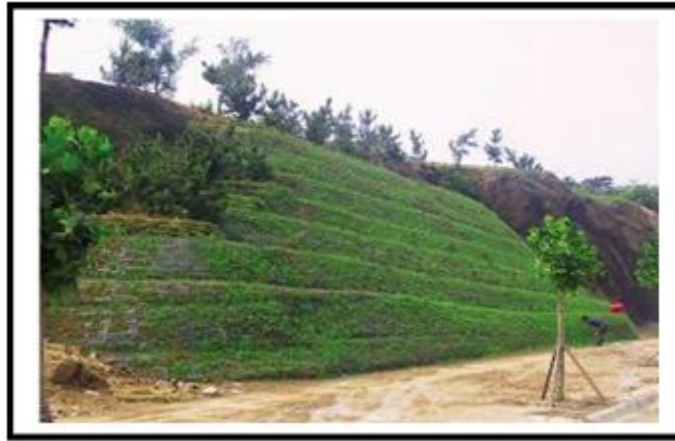
Figure I.21.L'implantation des plantes dans un talus [9]
