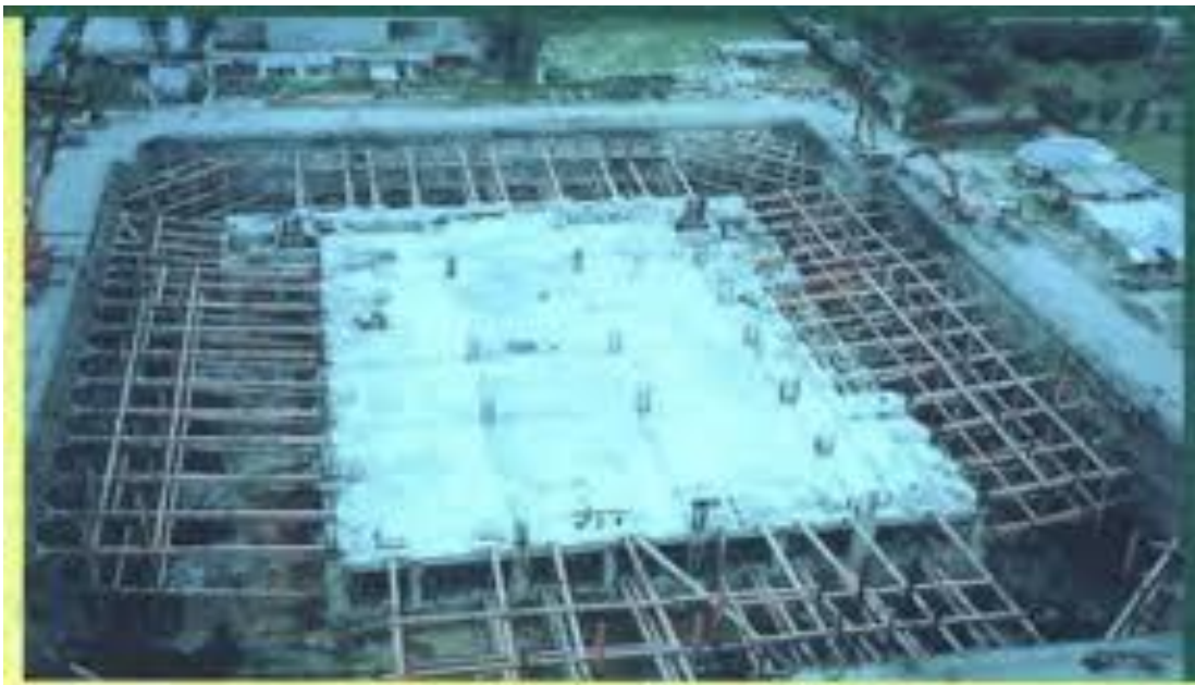
Figure I .51. Photo représentant la méthode d'excavation « Island » (Chang-Yu,2006)
