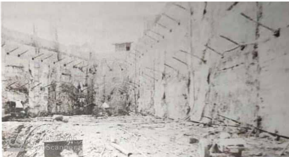
Figure I.47.Méthode d'excavation ancrée
