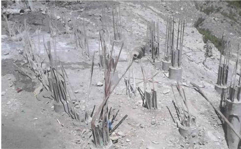
FigureI.25. Illustration montrant le clouage par micro pieux mixtes
