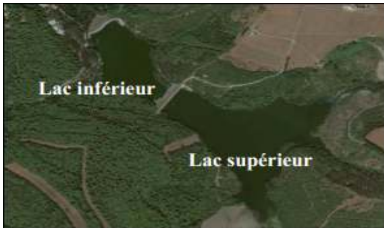
Fig. 15 : Situation géographique du barrage de la Réserve de Chasse de Zéralda. (Google Earth.,2017)
