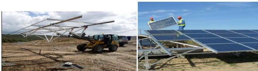
Figure I.5 : Construction de la centrale photovoltaïque de Puits Castan – Aude (Source EOLE-RES) A gauche : montage des structures – A droite : mise en place des panneaux sur les structures
