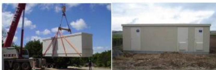
Figure I.6 : Installation d'un poste électrique (Source EOLE-RES)
