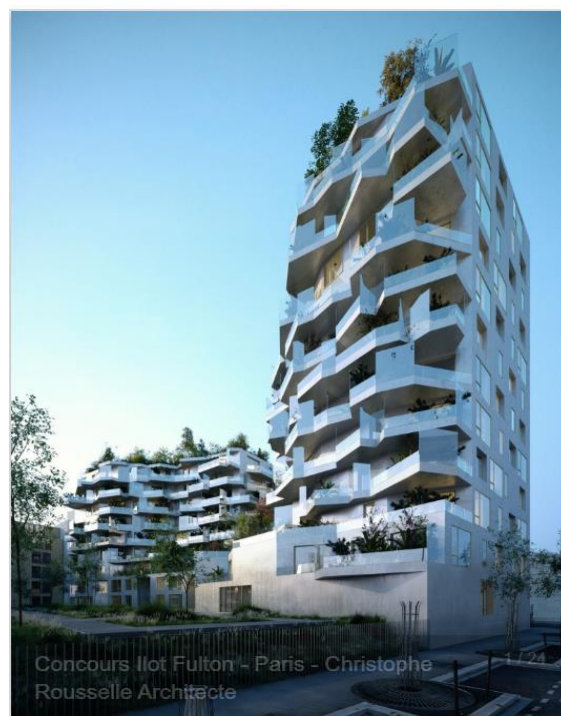
Figure 51 vue sur l'exemple de la résidence Fulton, à Paris, France. / Source: https://www.rousselle.eu/architecture?lightbox=datatime-irhhfw3
