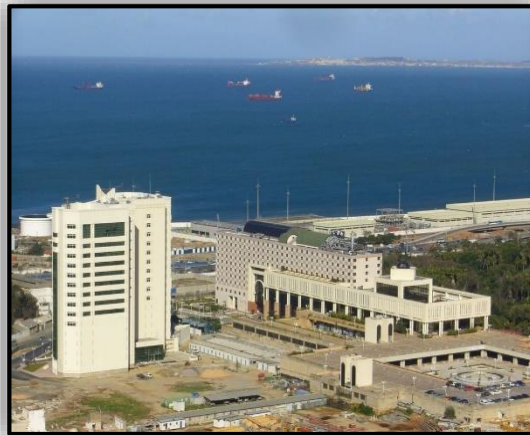
Figure 94 : hôtel Sofitel source : Google image
