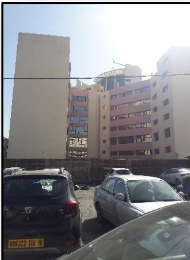
Figure 77 : des équipements clôturés à côté des axes structurant Source : prise par l'auteur
