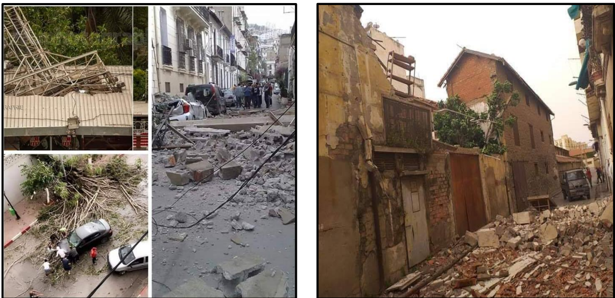
Figure 57 : effondrement de quelque construction source : page Facebook « Belcourt houmti »
