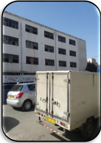
Figure 86 : équipement abandonnée source : pris par l'auteur
