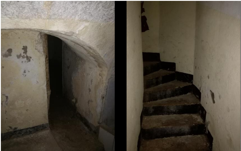
Fig 141: L'escalier du 2ème sous-sol
