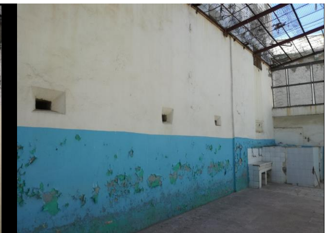
Fig 143: Les sorties de gaines d'aération
