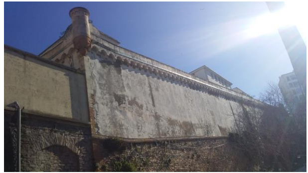
Fig 161: Le mur de ronde coté Ouest
