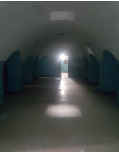
Fig 128: Le sous-sol de l'aile Est
