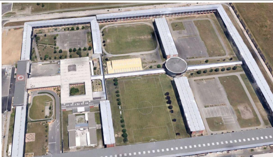
Figure 42 : Vue aérienne sur la prison de Muret.
