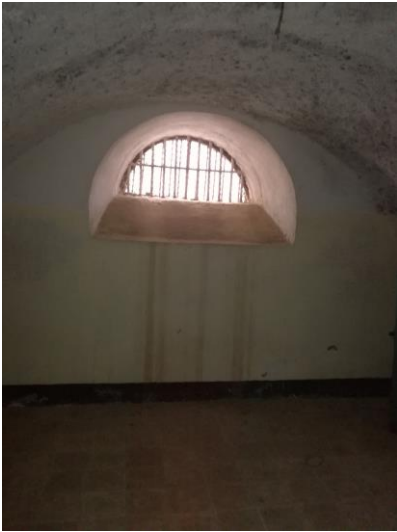
Fig 138: Une ouverture dans le Couloir des oubliettes
