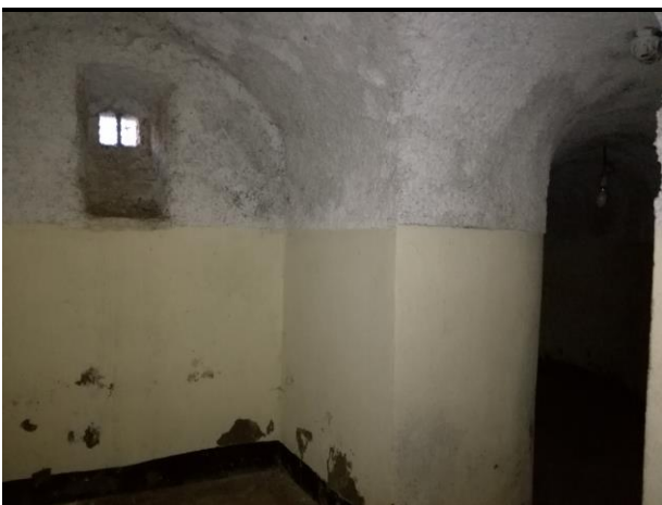
Fig 142: une cellule modifiée au 2ème sous-sol pour crée le passage entre les ailes
