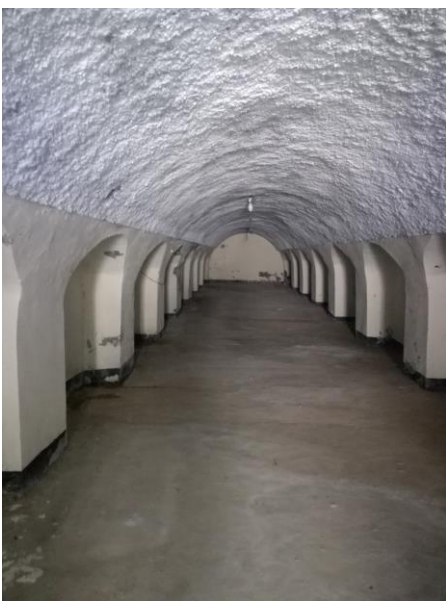
Fig 130: L'aile Ouest du 2 ème sous-sol.
