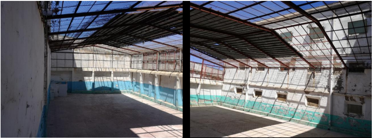
Fig 154 : Les grandes cours de l'ancienne prison coté ouest
