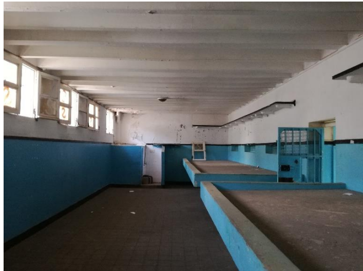
Fig 173 : Plancher nervuré
