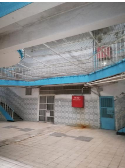
Fig 103: L'accès aux magasins
