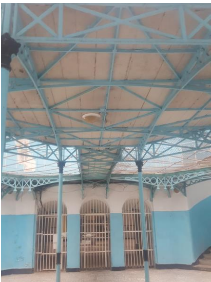
Fig 123: le système de construction du rond-point de surveillance
