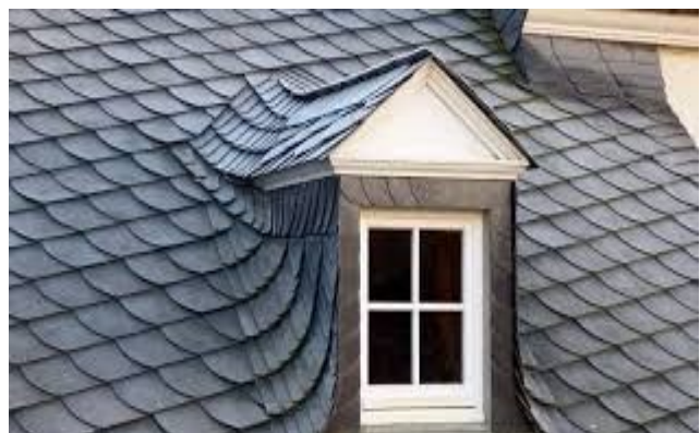
Figure 67 : La pose de la toiture
