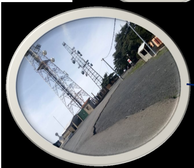
Figure 59 : vue sur l'antenne
