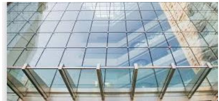
Figure 121: Mur rideau à double vitrage
