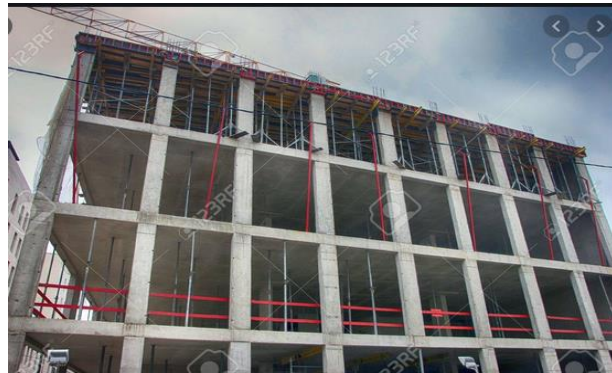
Figure 113: Système constructif poteau poutre
