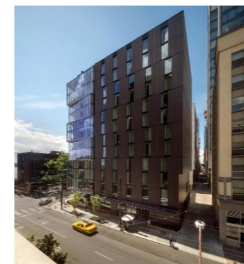
Figure 51: Façade revêtement de bois Source : Amush
