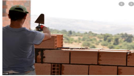
Figure 119: mur extérieur de 30 cm Source : Google image
