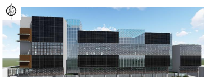
Figure 216 : Les panneaux photovoltaïque sur la façade sud Source: auteur
