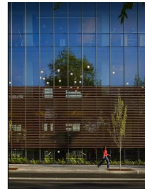
Figure 157 : Panneaux solaire photovoltaïque et brises soleil Source : pinterest .com
