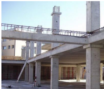
Figure 116:system poteau poutre
