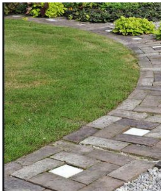
Figure 144: Le pavé drainé dans le terrain
