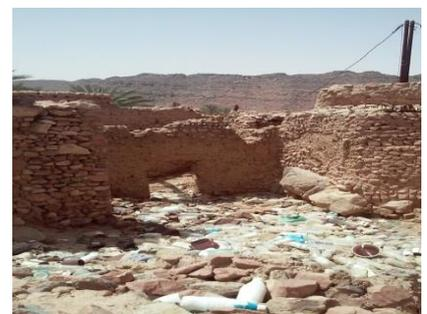
Fig. 16 à 18 : Sous l'effet du vieillissement des matériaux, du délaissement et de l'abandon des lieux, l'aghrem est dans un état de dégradation très avancée. Il est impératif d'enclencher un processus de revitalisation de cet aghrem. Ceci passe d'abord par son classement pour concrétiser la reconnaissance de ce patrimoine non renouvelable.
