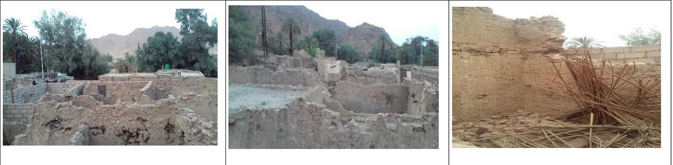
Fig. 34 à 35 : Etat de dégradation avancée du cadre bâti avec risque à terme de disparition de son intégrité physique.
