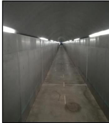
Figure 3.107 : Tunnel creusé dans le rocher, menant à la l'ascenseur
