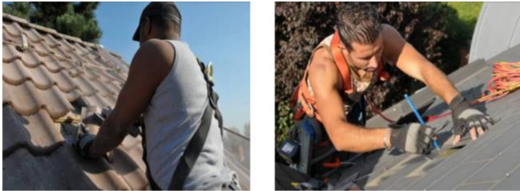
Figure (II-11): Avant l'installation des modules dans la toiture
