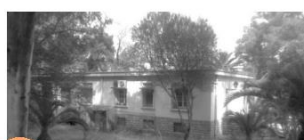
4 Logement des instituteurs
