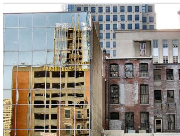
Figure 7: conséquences du non-respect des règles de visibilité, Cincinnati Ohio, États-Unis. Source : Wikipédia.
