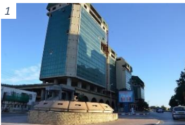
Figure 31: Immeuble Sahraoui. Source Wikipédia.
