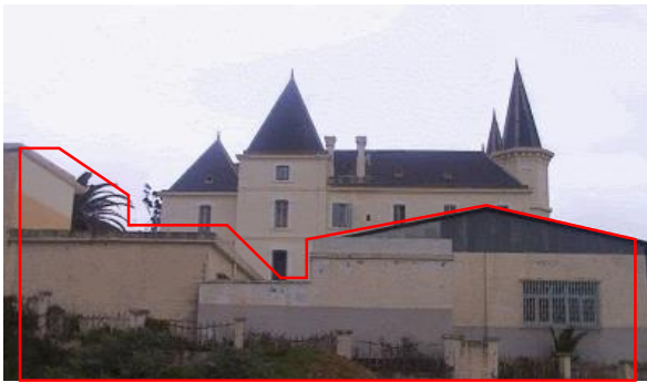
Figure 38 : Construction à 10 Mètres du château, Mars 2009. Source : www.kouanani.blogspot.com
