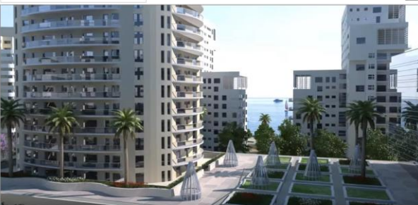
Vue sur immeuble de bureau îlot A4
