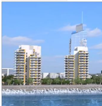
Vue sur les Tours d'habitat îlot A6-2
