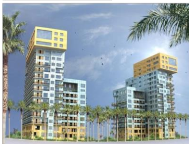
Vue en 3D sur les tours Océanes îlot A4
