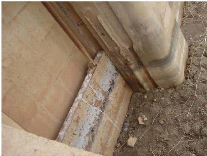
Figure 1.9 : Blocage des vannes de fond (Remini, 2011)
