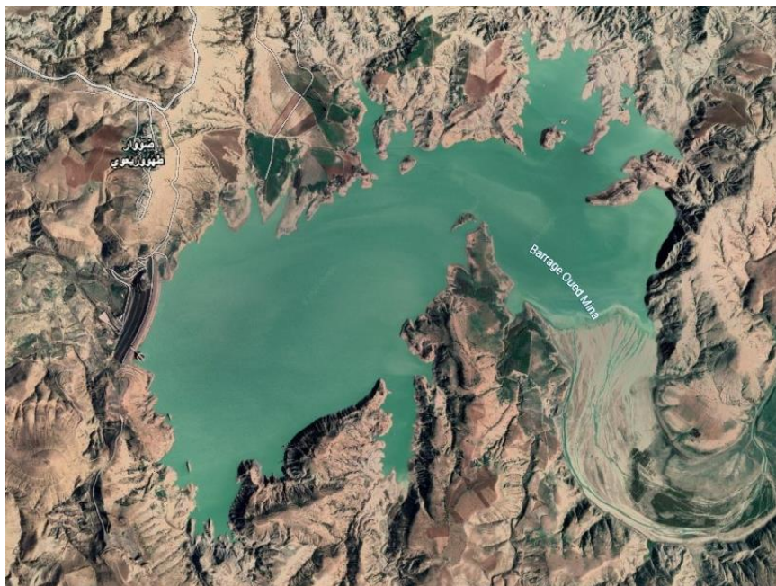
Figure 4.24 : Vue satellitaire sur le barrage Sidi Mohamad Ben Aouda
