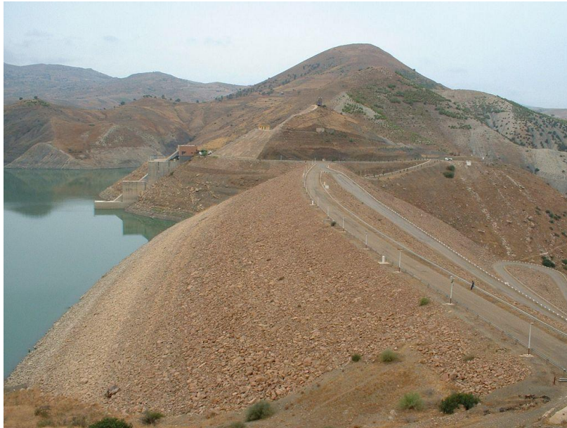
Figure 4.27 : Barrage Sidi Yacoub (Cliché : ANBT)
