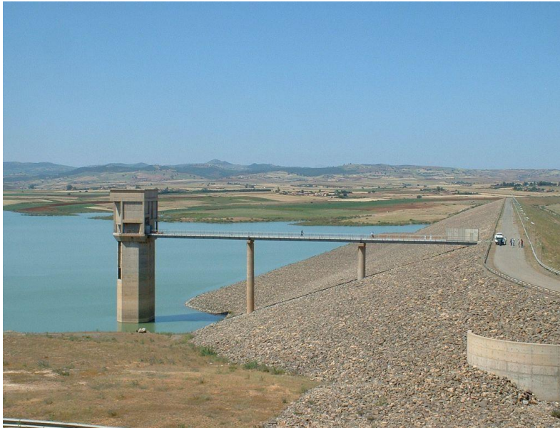
Figure 4.13 : Barrage Harreza (Cliché : ANBT)
