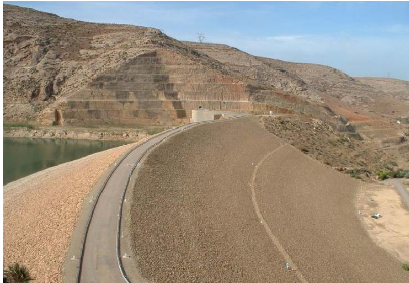
Figure 4.9 : Barrage Gargar (Cliché : ANBT)
