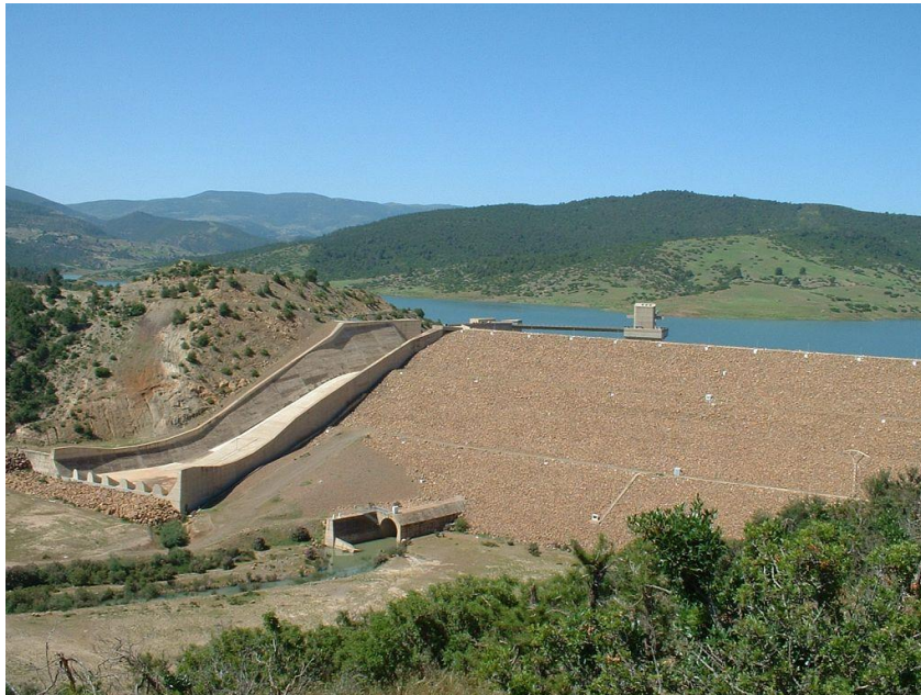
Figure 4.7 : Barrage Deurdeur (Cliché : ANBT)
