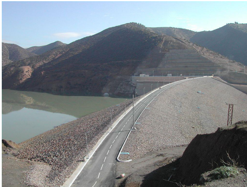
Figure 4.25 : Barrage Sidi Mohamad Ben Taiba (Cliché : ANBT)
