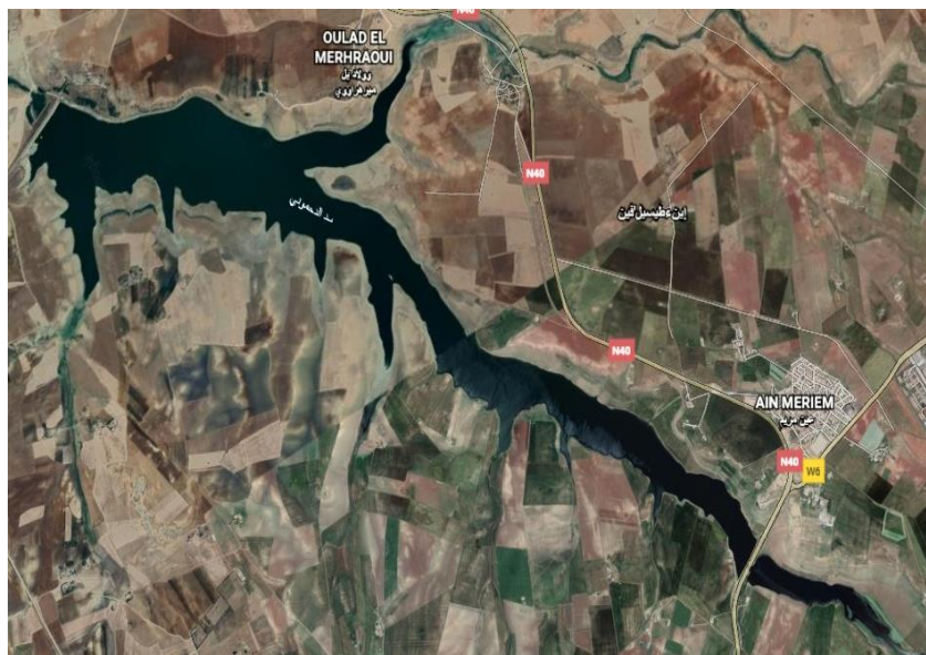
Figure 4.6 : Vue satellitaire sur le barrage Dahmouni (Cliché Google Earth, 2020)
