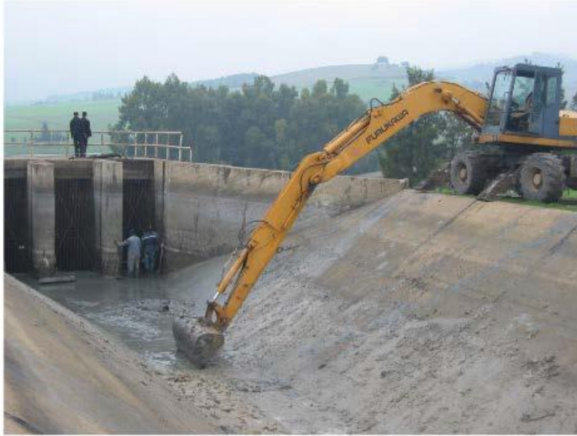
Figure 1.10 : Curage d'un canal par les moyens mécaniques (OPIM, 2008).
