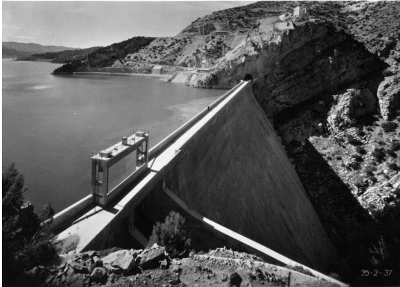
Figure 4.19 : Barrage Oued el Fodda (Source : www.canalblog.com , Cliché : 1937)
