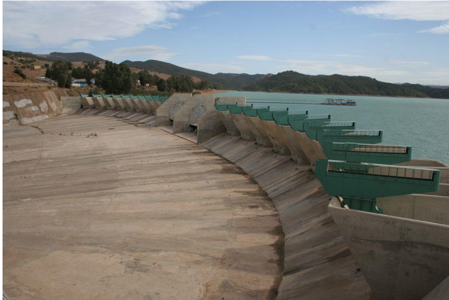
Figure 4.11 : Barrage de Ghrib (Cliché : ANBT)
