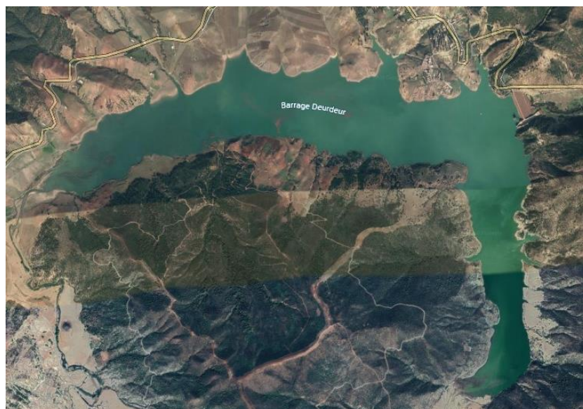
Figure 4.8 : Vue satellitaire sur le barrage Deurdeur (Cliché : Google Earth, 2020)
