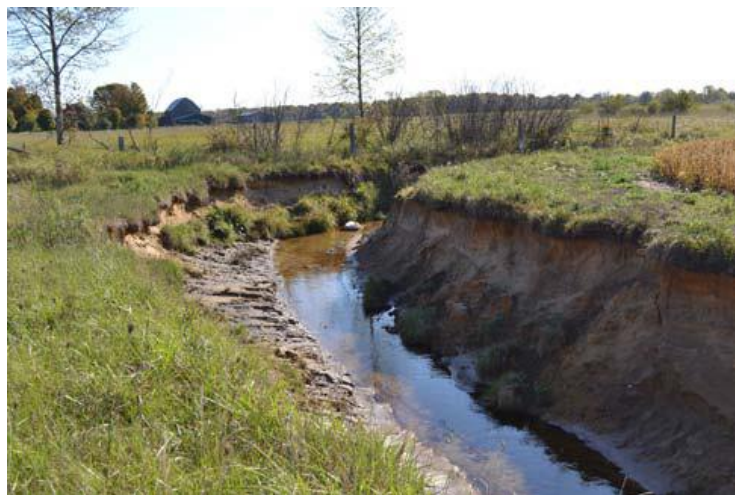
Figure 1.5 : L'érosion des berges résulte du sapement et de l'affouillement des berges des cours d'eau naturels et des canaux de drainage. (Cliché : Jim Ritter, 2012)
