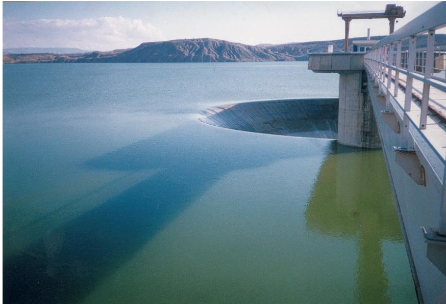
Figure 4.23 : Barrage Sidi Mohamad Ben Aouda (Cliché : ANBT)
