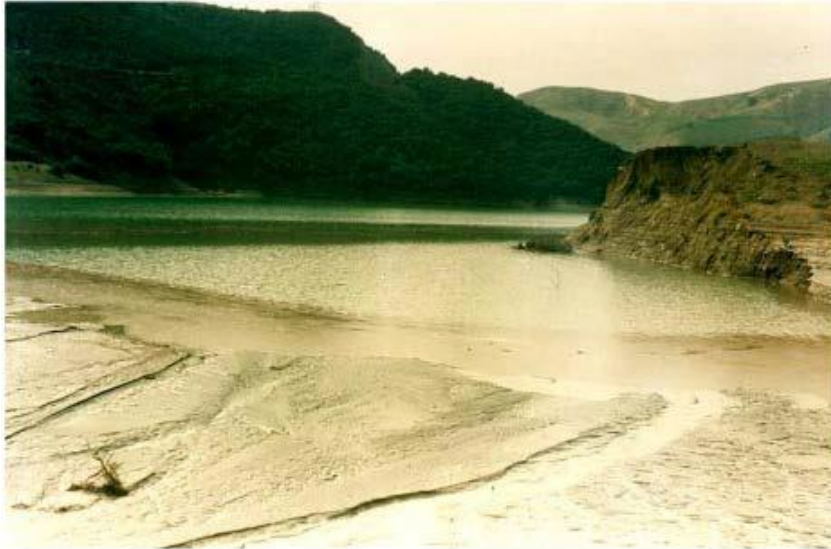
Figure 1.8 : Envasement du barrage d'Ighil Emda (Remini et Ouaret, 2004)
