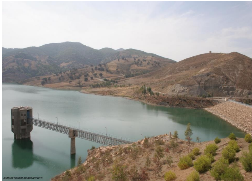
Figure 4.15 : Barrage Koudiat Rosfa (Cliché : B.H, 2011)
