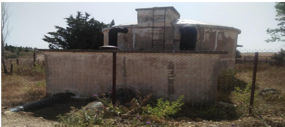
Photo 4.14. Réservoir Tampon Kadri vers la commune de Souk-Ahras
