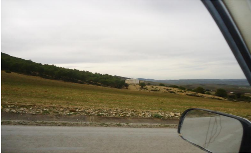
Photo 4.18. Réservoir Tampon vers la commune de Sidi Fredj
