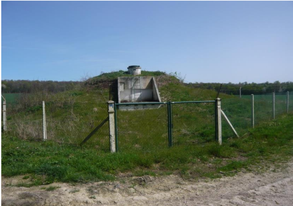
Photo 4.1. Réservoir enterré
