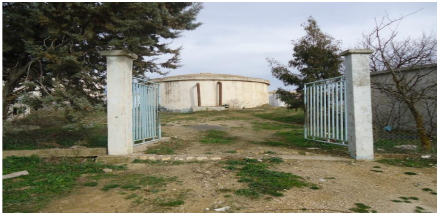
Photo 4.17. Réservoir Tampon vers la commune de Merahna
