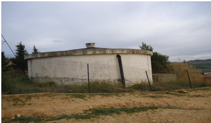
Photo 4.19. Réservoir Tampon vers la commune d'Ouillen
